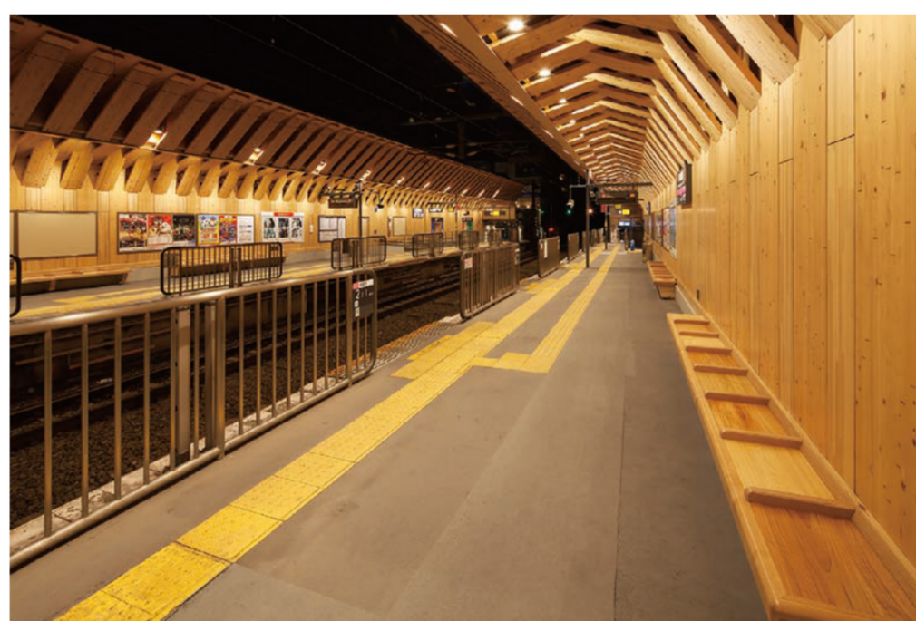
センサー付固定式ホーム柵
